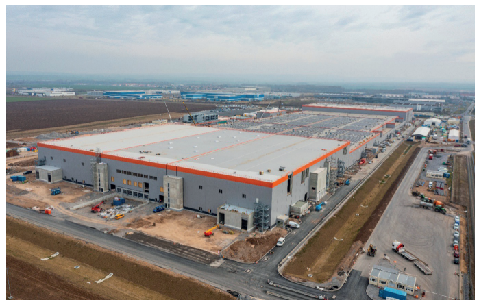
Aktuell noch eine Baustelle: Werk G2 für die Batteriezellfertigung
